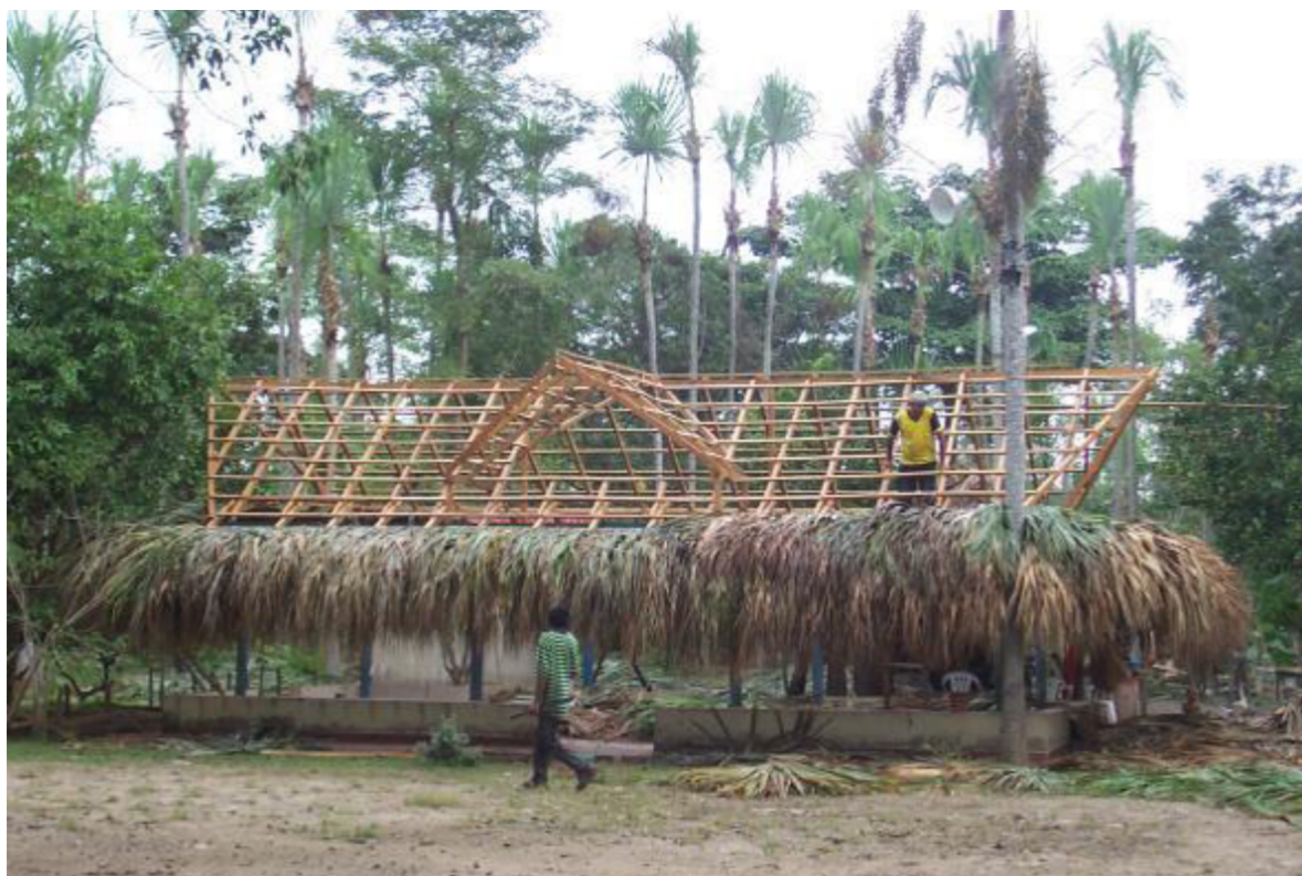
Figura 13. Momento de empaje de una casa comunitaria con hojas de palma amarga en el departamento de Sucre (Tomado de Carsucre & Cudesac, 2007).
